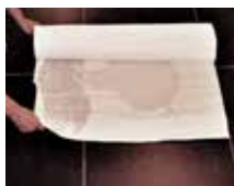
Zorg voor een effen en droge ondergrond op kamertemperatuur. Leg de sticker open en laat die 24 u ontroid liggen. Breng de sticker binnen de 6 weken na aankoop aan.
