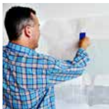
Hou de sticker vast en wrijf met de spatel de sticker goed vast aan de muur.
