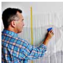
Druk de ene kant van de sticker goed aan met de spatel.
