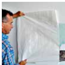
Hou de folie zo dicht mogelijk bij de muur tijdens het verwijderen.
